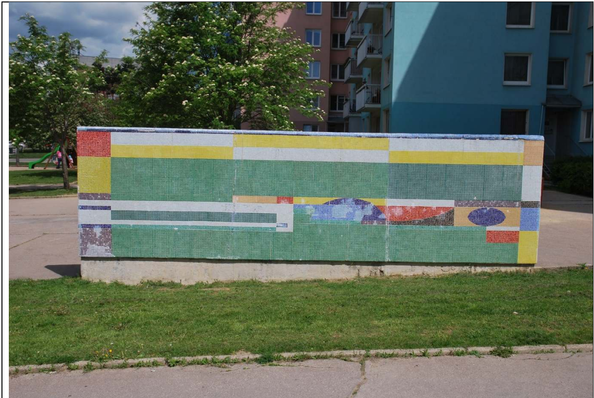
Stav před restaurováním, jižní stěna
