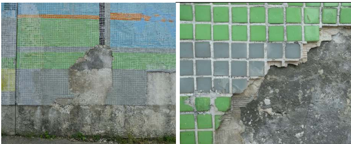
Obr. 23 Mozaika „Přítomnost člověka“ B. Matala – severní stěna, stav před restaurováním – detaily poškození, ztráty mozaikových kostek. Foto Z. Křenková
