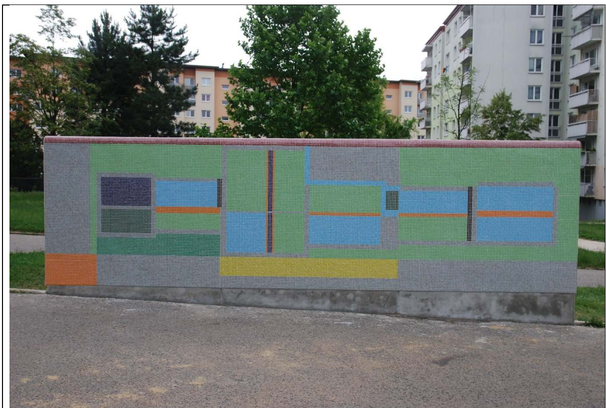
Stav po restaurování, severní stěna
