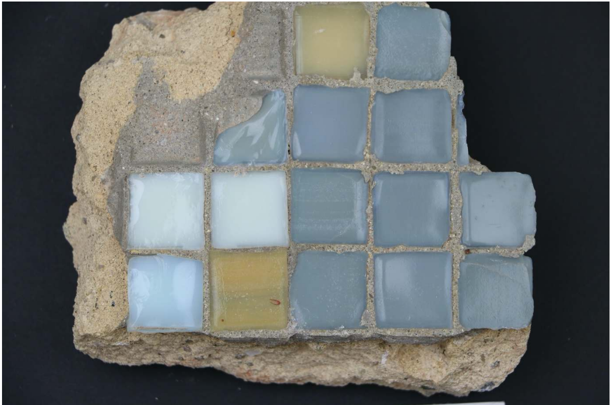
Obklad budovy bývalé samoobsluhy v Desné z hladké lité mozaiky, 1968. Foto I. Kučerová
