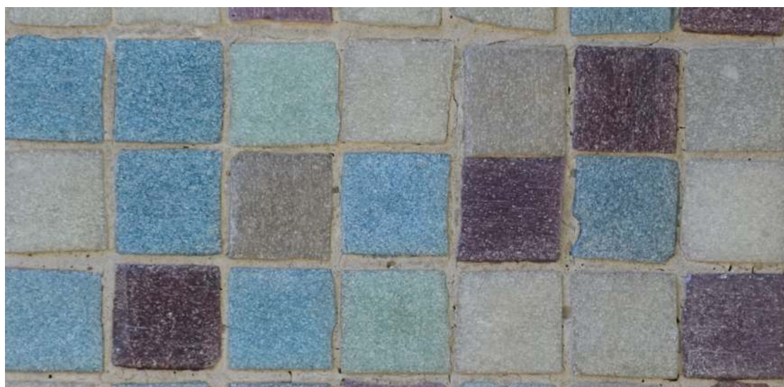
Obr. 13 Detail obkladu Katastrálního úřadu v Liberci – pískovaná litá mozaika. Foto I. Kučerová
