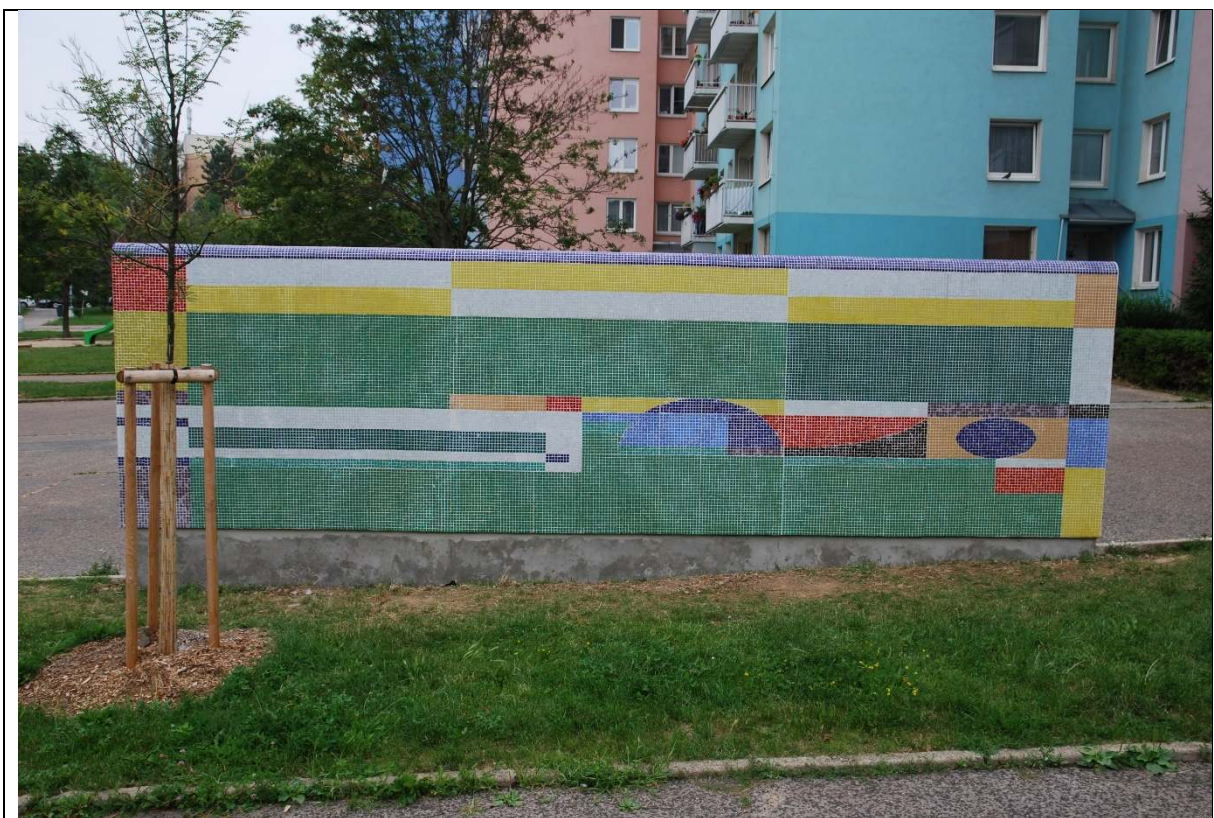
Stav po restaurování, jižní stěna
