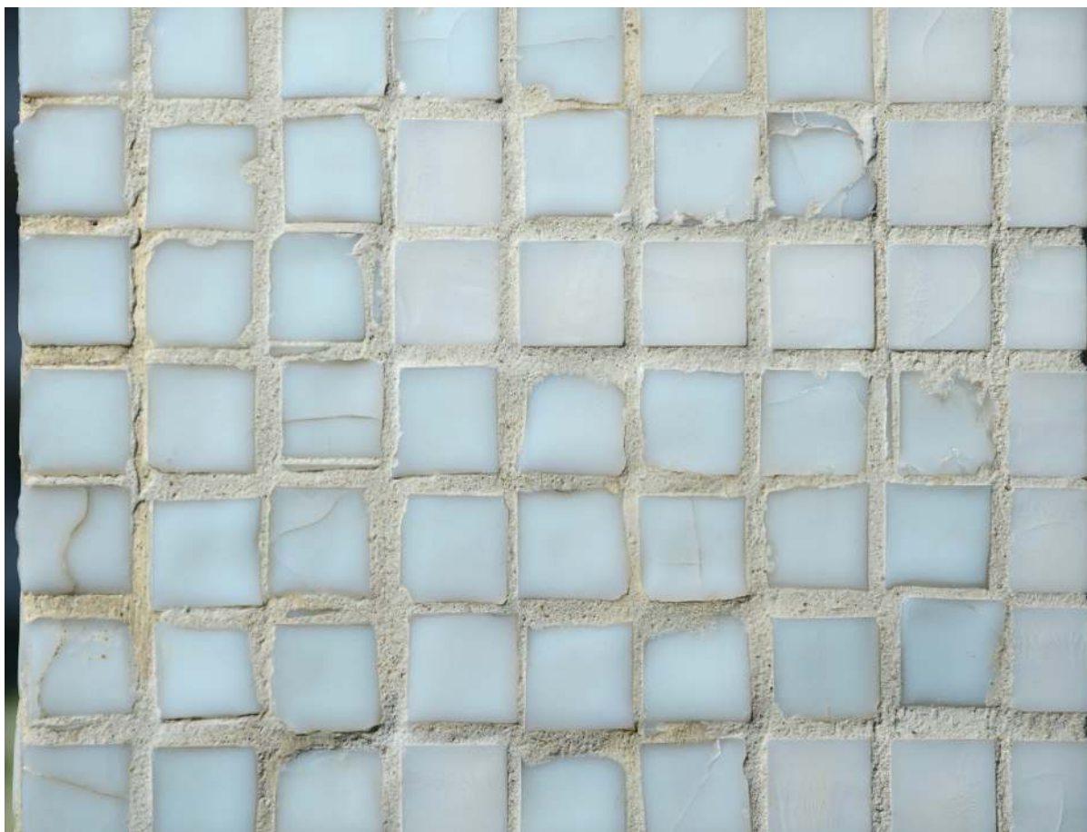
Obr. 26 Stav po restaurování – detail doplnění mozaiky replikami kostek bílé barvy. Foto I, Kučerová
