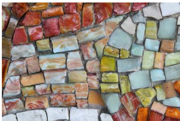
Obr. 2. Detail abstraktní mozaiky Antonína Procházky, Chlumec, 1976. Mozaika je vysázena z kostek různé velikosti, mozaikové sklo obsahuje ve hmotě značné množství šlír, tj. sklo je ve hmotě nesterjnoměrně zbarveno (např. bílá kostka s okrovými šmouhami nebo červená kostka s bílými šmouhami). Foto M. Kněžů Knížová
